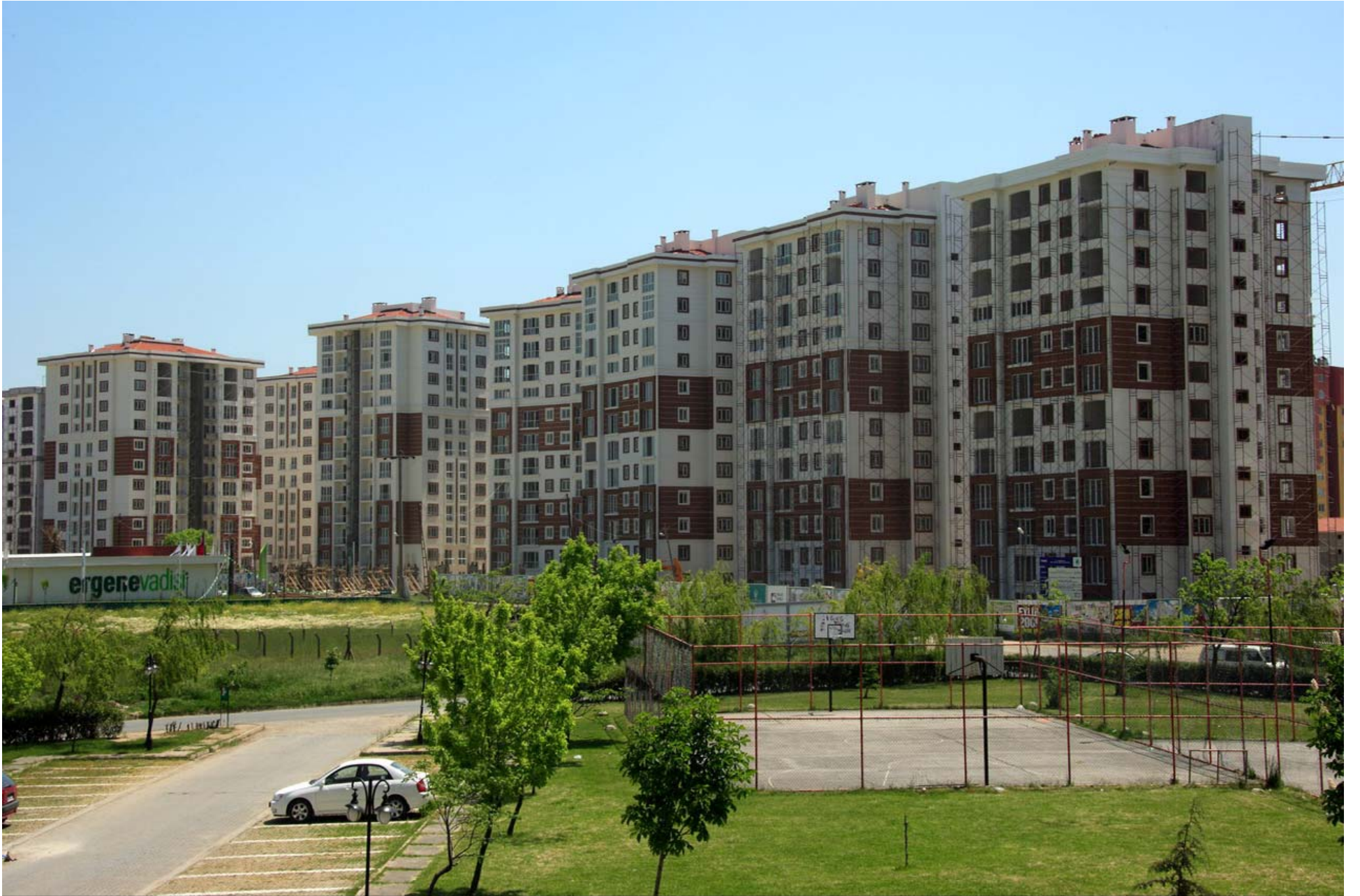
TEKİRDAĞ - ÇORLU KAYNAK GELİŞTİRME UYGULAMASI
