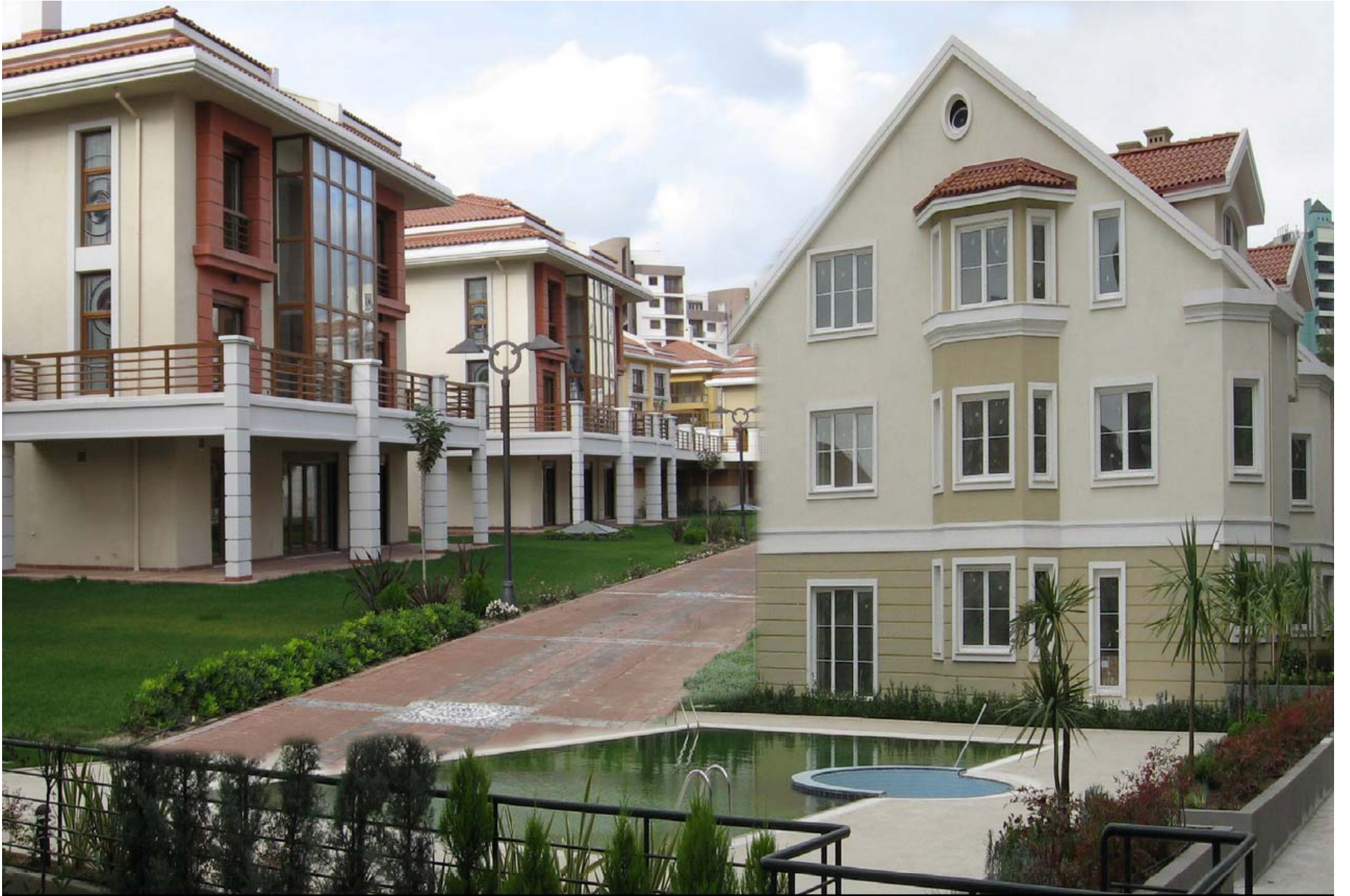
İSTANBUL - BAHÇEŞEHİR KAYNAK GELİŞTİRME UYGULAMASI
